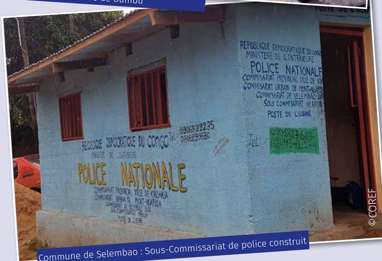
Construction de cinq bureaux de quartier dans la Commune de Bumbu
