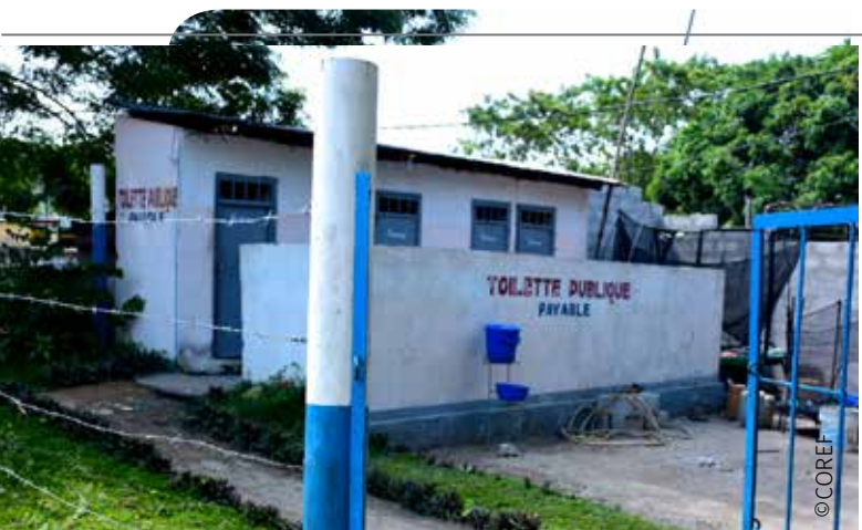
■ Toilettes publiques construites dans la Commune de la N'sele
